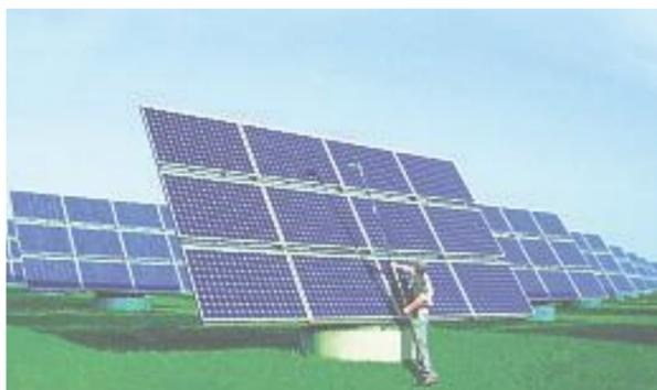
Mit dem Unger-Stangensystem können auch Solaranlagen noch in einer Höhe von bis zu 21 Metern gereinigt werden. Foto: Unger
