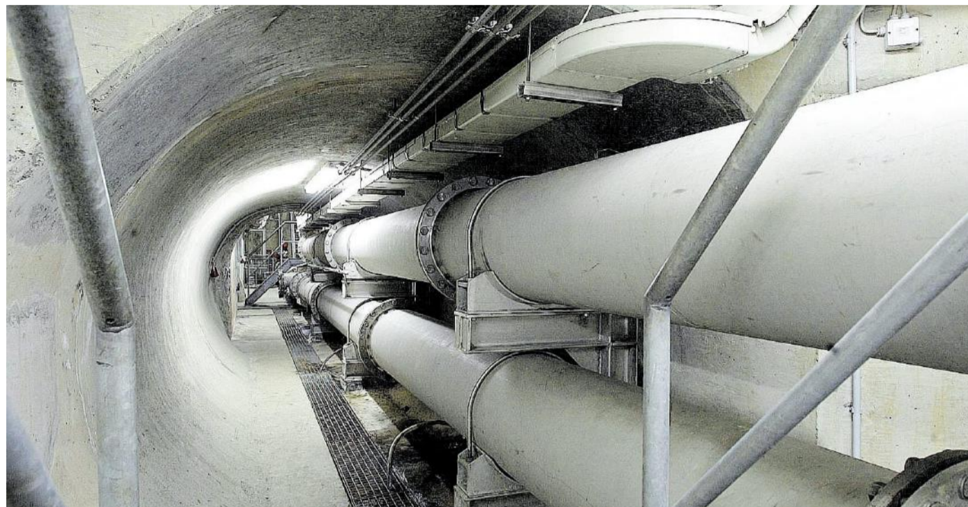
An der Eschbachtalsperre (unten) können Besucher am Samstag das Innenleben der Staumauer erforschen.
